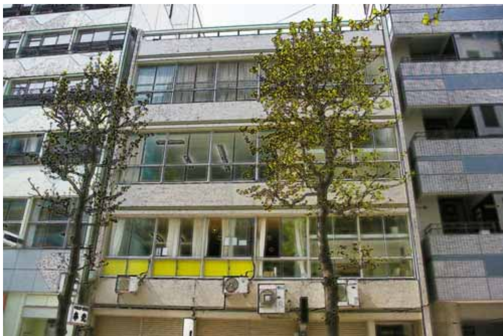
関内の洋服会館の外観 (2F が市民セクターよこはま事務所、3F がよこはま市民共同オフィス)
